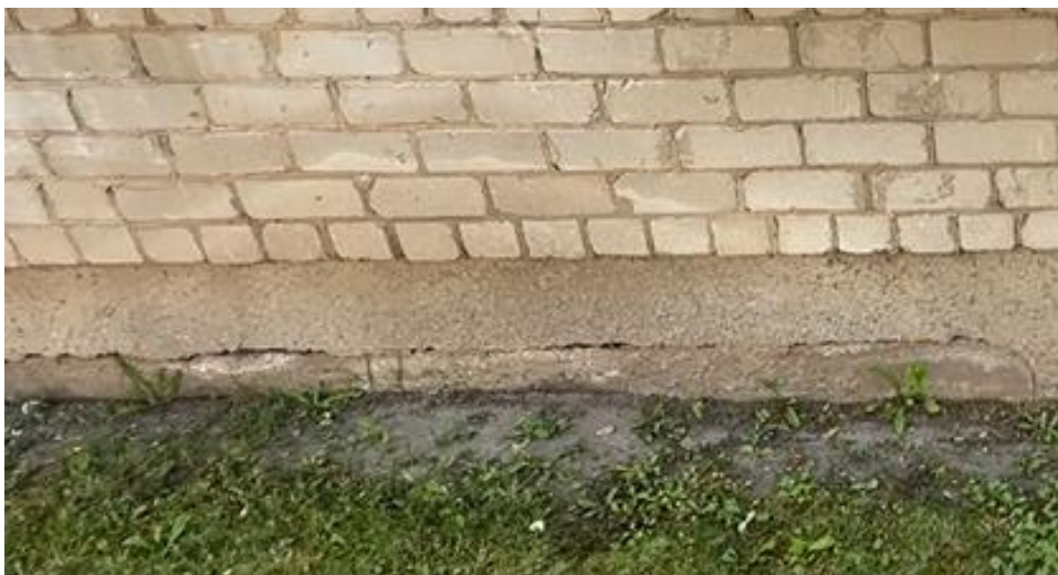
11 pav. Įtrūkimas ties pamatinių blokų sujungimu
