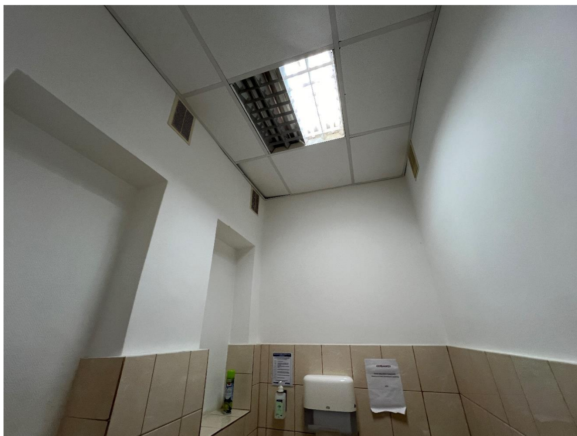
19 pav. Ventiliacinių angų fotografacija (tualetai)
